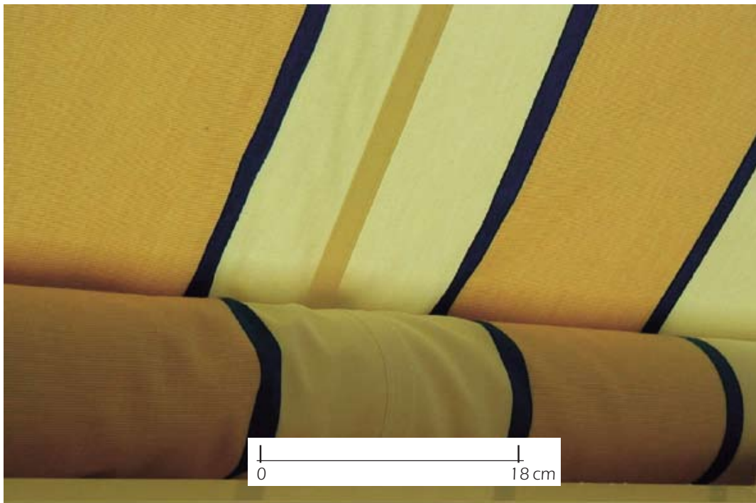
Bild 9.1.12 Tillåtet upprullningsveck på duken
